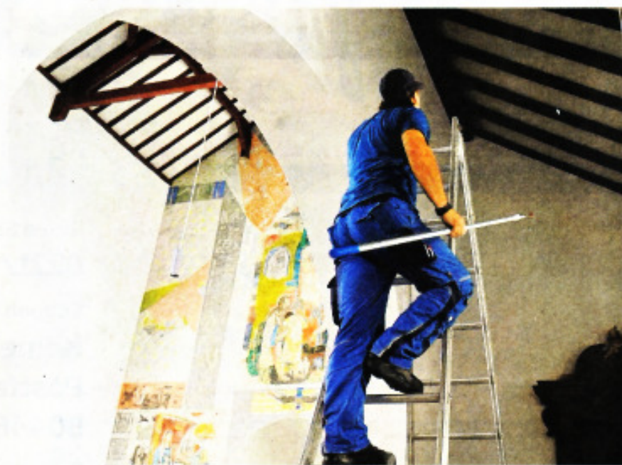
Das Dach wurde von innen erneuert und die Decke neu gestrichen.
